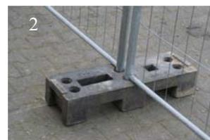
Die Bauzäune werden mit soliden Bauzaanschellen miteinander verbunden.
