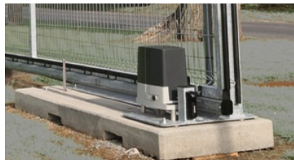
Ansicht mit Bodenplatte
