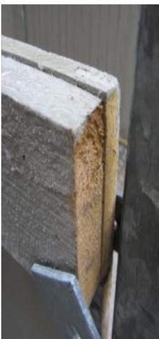
Die Brüstungen und Rückwände sind aus kesseldruckimprägnierten Holz aus Nut- und Federbretter. Die vernagelten Querriegel sind 30 mm stark, die vertikalen Nut- und Federbretter sind 20 mm stark. Beide Teile werden ebenfalls mit den Durchgangsbügel an die entsprechenden Laschen geschraubt bzw. geklemmt.
